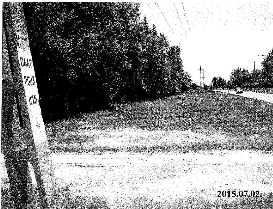
1. számú kép: Ipari út felőli telekhatár
